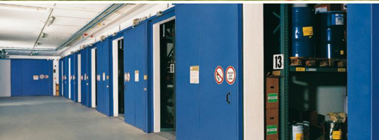
Zahlreiche Ausstattungsvarianten – natürlich mit bauaufsichtlicher Zulassung – ermöglichen eine objektspezifische Anpassung der ein- bzw. zweiflügeligen Feuerschutz-Schiebetore. So können dank einer Feststellanlage mit Auslösevorrichtung die Tore überwiegend geöffnet bleiben und schließen im Brandfall zuverlässig. Mit Freilauffunktion lassen sich die Tore in jeder Position abstellen. Schlupftüren sorgen für bequemen Durchgang bei geschlossenem Tor.
