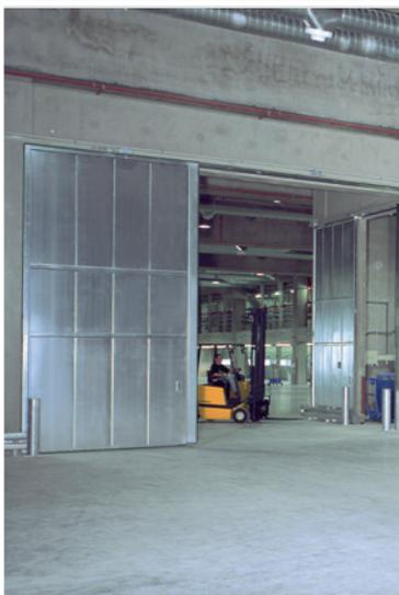
Stahlschiebetore außerhalb des Zulassungsbereiches lassen sich in Sonderfällen auch mit Feuerschutzfunktion, jedoch ohne Zulassung, ausführen. Die Tore werden transportgünstig in Einzelsegmenten angeliefert.
